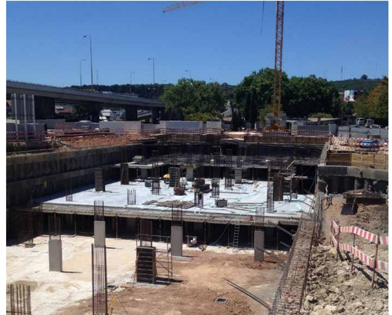
A Obra consiste na construção de um Parque de estacionamento Subterrâneo com uma área total de 9.256,50m<sup>2</sup>, distribuídos por 3 pisos enterrados, tendo cada um cerca de 3.085,50m<sup>2</sup>, com uma capacidade total de 301 lugares de estacionamento.
